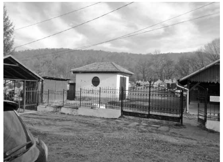
Die Kapelle vom Galtberger Friedhof mit neuem Dach
