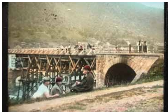
Gesprengte, nach dem Krieg wieder aufgebaute Steinbrücke über den Alt bei Căineni, 1922. Handkoloriertes Glasdias. *1)
