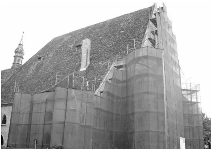
Die eingerüstete Klosterkirche
