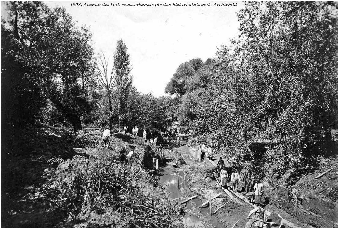
1903, Aushub des Unterwasserkanals für das Elektrizitätswerk, Archivbild
