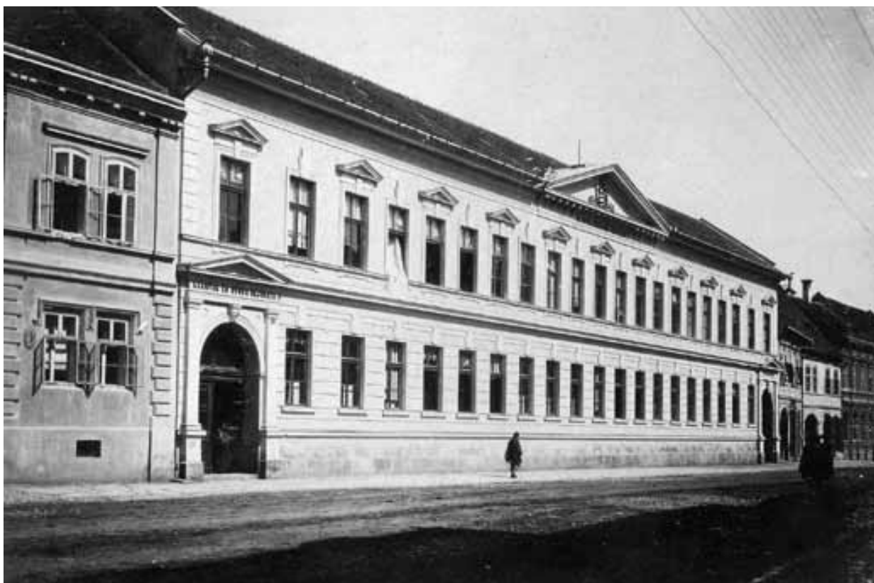
Das rum. Gymnasium, 1897 als ehemalige ungarische Knabenschule erbaut, ab 1918 „Kronprinz-Nicolae-Lyzeum“ und heute „Colegiul National Mircea Eliade“, Archivfoto: Roth
