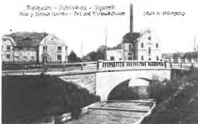
Bad und Elektrizitätswerk am Mühlengraben um 1920. Archiv Isa Leonhardt
