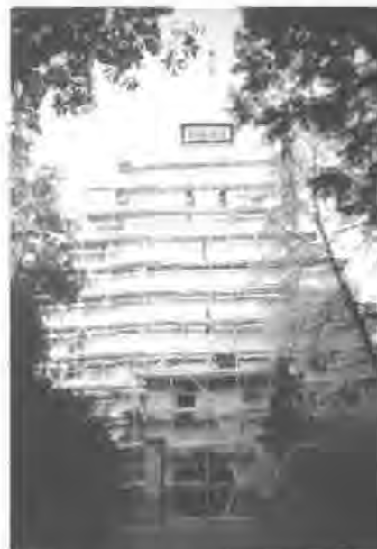
Gerüst für den Außenputz an der Bergkirche, September 1996. Foto: Walter Lingner
