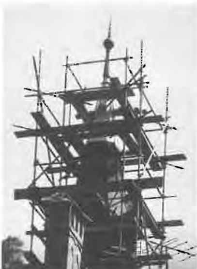
Das Bergschultürmchen in Reparatur. Foto: Kurt Müller
